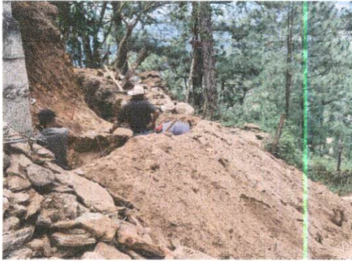
Foto 1: Reparación del muro de contención e instalación de malla que se encuentra en el establecimiento
