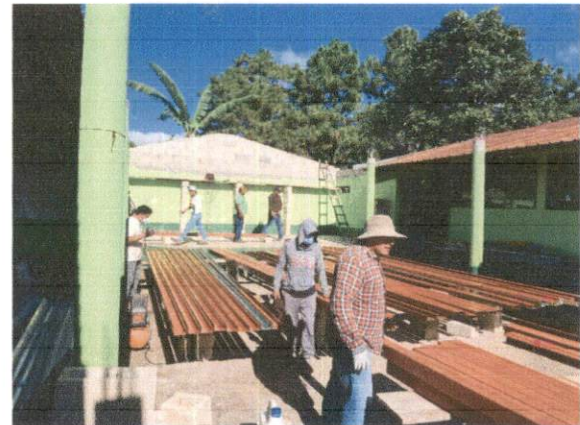
Foto 4: Estructura, entechado, instalación de canales, instalación de sistema eléctrico
